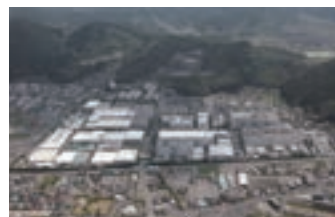
鹿児島国分工場 Kagoshima Kokubu Plant
